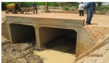
Sur le tronçon de la route Koutiala-N'Golonianasso, l'étude a prévu de construire un dalot double sans prévoir une étude hydraulique préalable qui permet de caler l'ouvrage en hauteur et largeur permettant le passage normal des eaux sans charge.
