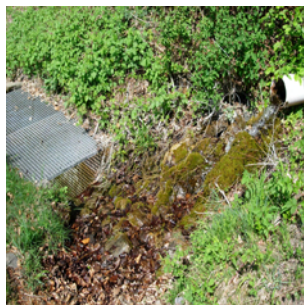
Quelle verrohrt und gefasst
