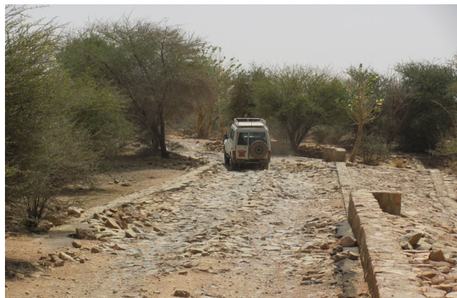
Seuil-radier dégradé entre Kalaït et Arada
