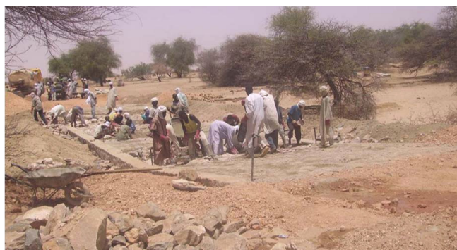
Construction d'un seuil-radier
