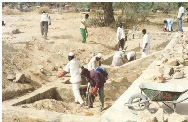
Maçons réalisant un ouvrage en maçonnerie de pierres
