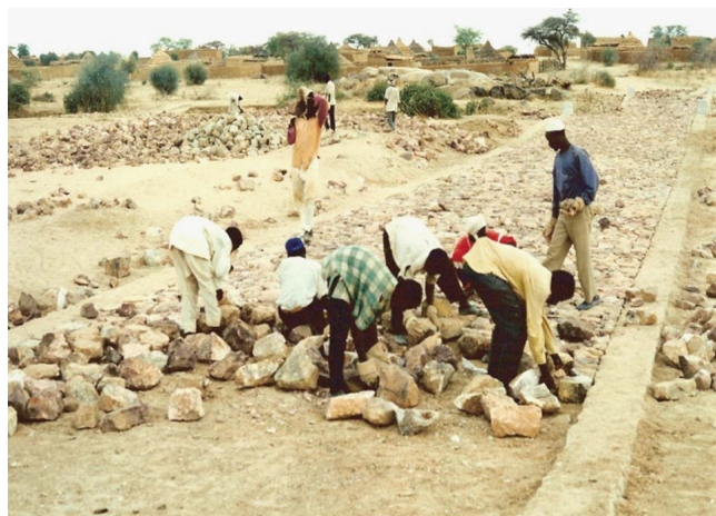
Enrochement d'un ouvrage
