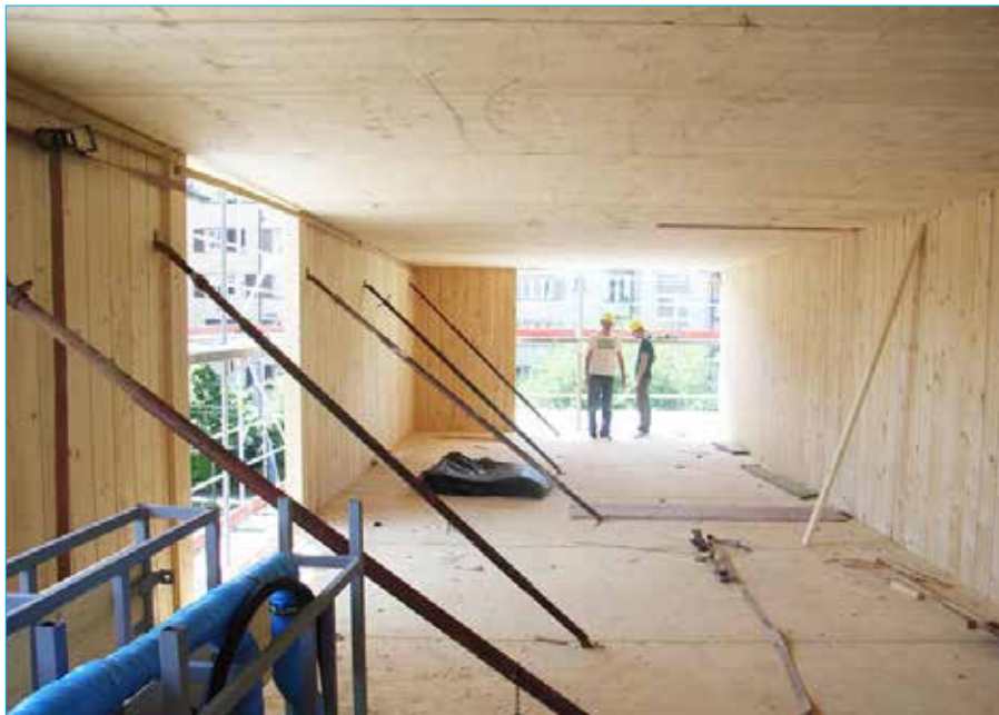
Ansicht des Rohbaus im 2000-Watt-Gebäude «Badenerstrasse», das mit tragenden Holzwänden erstellt worden ist. Dasselbe Konstruktionsprinzip soll auch bei Haus J auf dem Huniker Areal zum Einsatz kommen.
