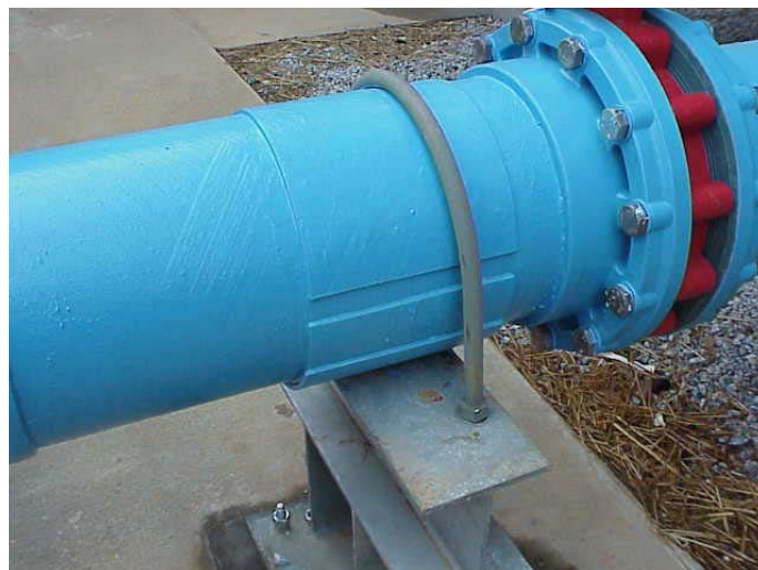
Abb. 2: Solide Rohrhalterung mittels U-Bolzen (ALA 2002)
