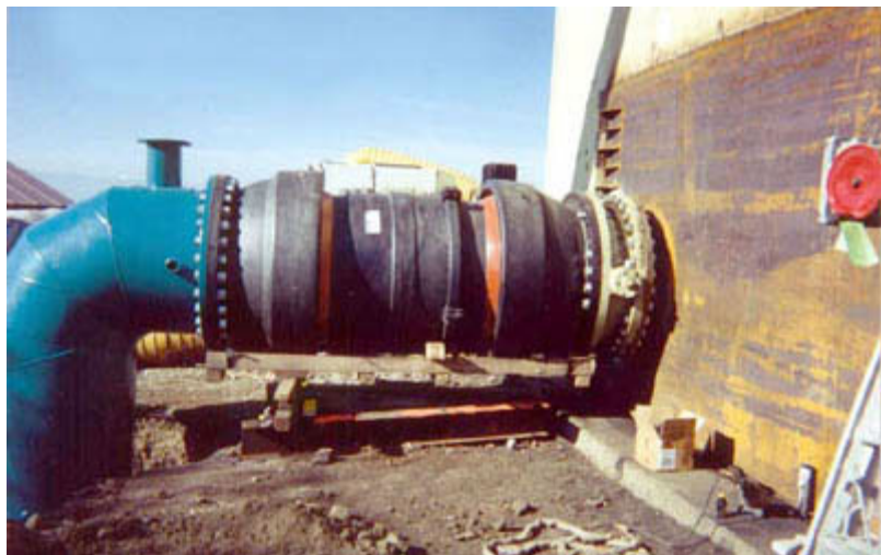
Abb. 5.6: Flexibler Rohranschluss an ein Tankbauwerk ( http://www.sccitanks.com )
