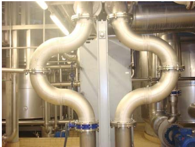
Abb. 5.5: flexible Rohrleitungen mit U-förmigen Dehnungsbereichen ( http://www.z-montagen.ch )
