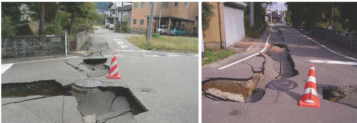
Abb. 3.2: Kollaps von Kanalisationsrohrleitungen beim Niigata Ken Erdbeben in Japan von 2004 (Scawthorn et al. 2006)
