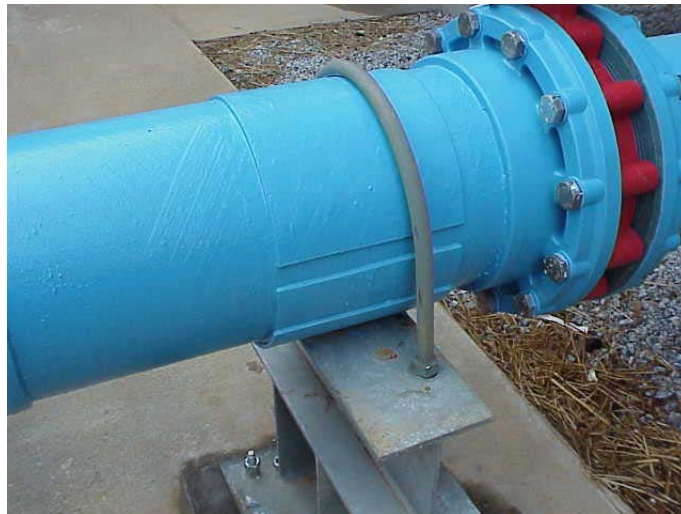
Abb. 5.8: Solide Rohrhalterung mittels U-Bolzen (ALA 2002)
