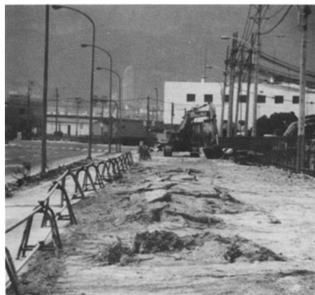
Abb. 3.4: Auftreiben einer 500 mm Rohrleitung durch Bodenverflüssigung beim 1995 Hyokogen-Nambu (Kobe) Erdbeben in Japan (NIST 1996)
