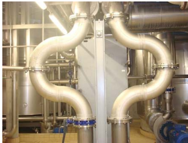
Abb. 9: Flexible Rohrleitungen mit U-förmigen Dehnungsbereichen ( http://www.z-montagen.ch )
