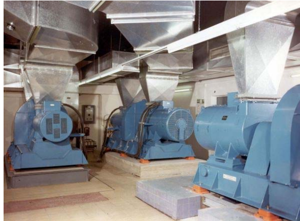
Abb. 13: Schwingungsisolation einer Lüftungsanlage mit Federelementen ( http://www.gerb.com )
