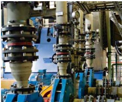
Abb. 7: Flexible Rohrleitungsanschlüsse mit Bewegungsmanschetten, a) aus Gummi ( http://www.ditec-kt.de ) und b) aus Metall ( http://www.jetaerators.com/ )
