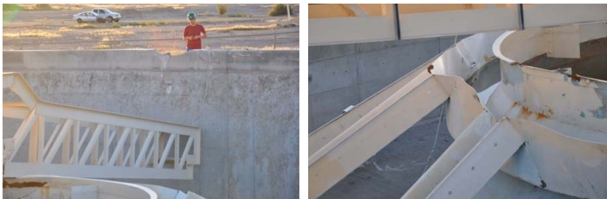
Abb. 3.8: Schädigungen eines Klärbeckens in Calexio Kalifornien beim Sierra El Mayor Erdbeben 2010 (Hutchison et al. 2010)
