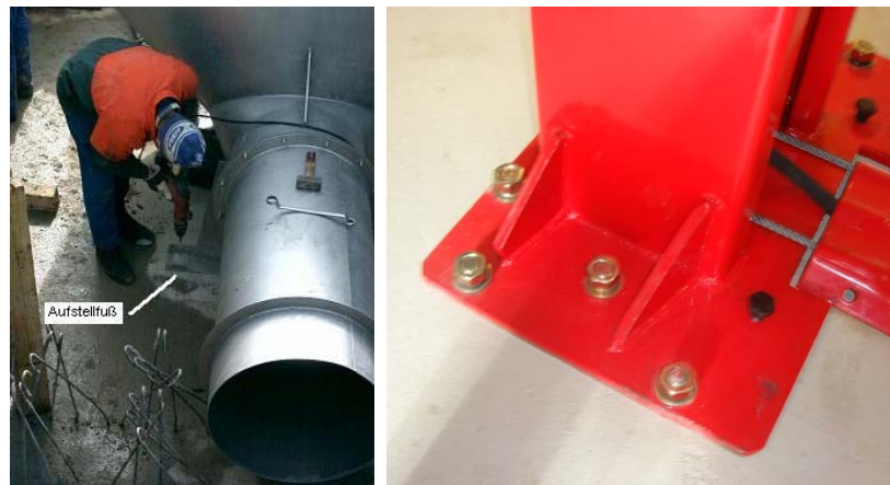
Abb. 5.15: Verankerung von Behältern und Gerätefüßen (HB-Technik, Profitexx)
