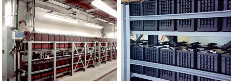
Abb. 5.12: Erdbebenerechte unabhängige Stromversorgung mit Sicherung der Batterien gegen Umkippen und Herausfallen (JMAEG, Phasor Corporation)
