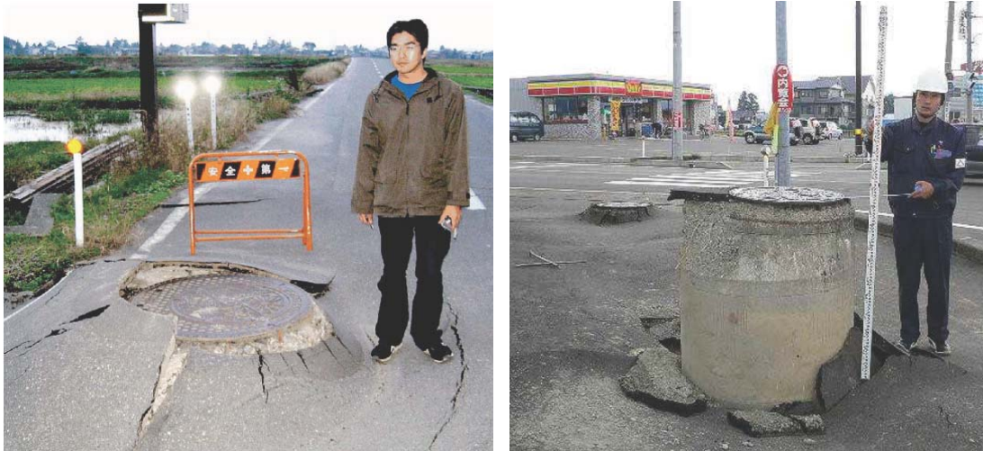
Abb. 3.3: Aufschwimmen von Kontrollschächten durch Bodenverflüssigung beim Niigata Ken Erdbeben in Japan von 2004 (Scawthorn et al. 2006)
