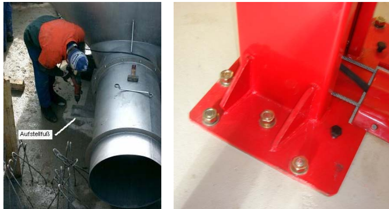
Abb. 10: Verankerung von Behältern und Gerätefüßen (HB-Technik, Profitexx)
