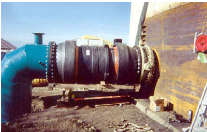
Abb. 6: Flexibler Rohranschluss an ein Tankbauwerk ( http://www.sccitanks.com )
