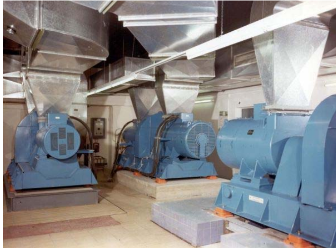
Abb. 5.20: Schwingungsisolierung einer Lüftungsanlage mit Federelementen ( http://www.gerb.com )
