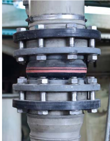
Abb. 8: Flexible Rohrmuffe aus Gummi ( http://www.ditec-kt.de )
