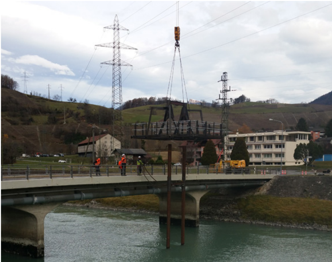
Figure 20 Installation de la plateforme sur le site de Lavey le 23.11.2016.
