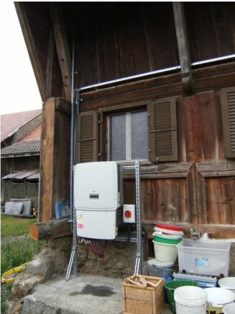
**Figur 19:** Wechselrichteraufstellung
