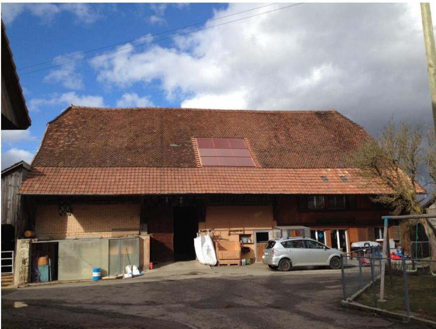
**Figur 2:** Testinstallation von neun a-Si Modulen zur Verifizierung von Farbe, Glastextur und Format
