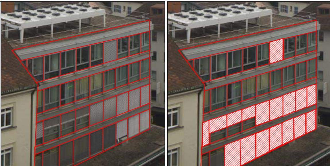
Abbildung 8 Bürogebäude mit Rafflamellen mit Fenstermaske, ohne Direktstrahlung; Anteil verschattete Fenster im Beispiel: 15.5 von 36 Fenstern sind verschattet = 43%, Fensteranteil Fassade = 74%, Glasanteil Fassade = 59%
