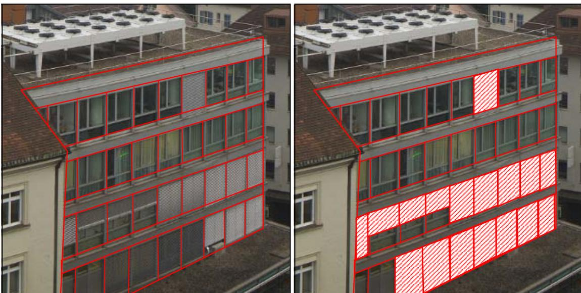
Abbildung 1 Bürogebäude mit Rafflamellen, rechts mit Markierung der verschatteten Fensterfläche
