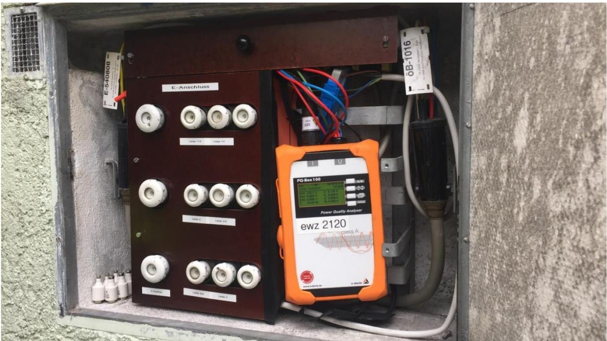
Abbildung 4: Installierter Netzanalysator im Schalttableau der Anlage
