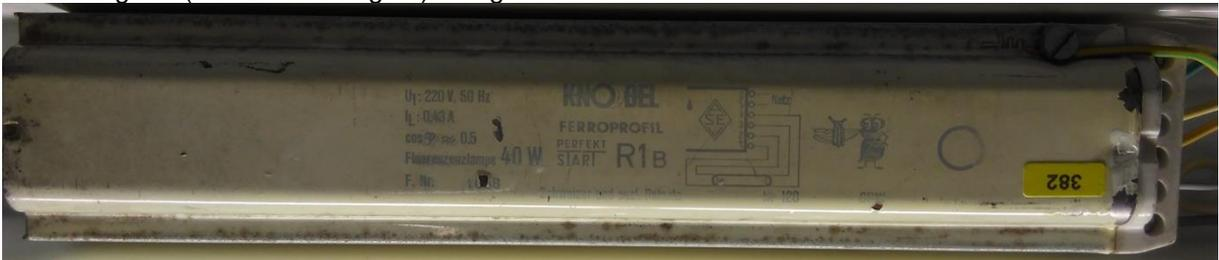
Abbildung 10: konventionelles Vorschaltgerät Knobel Ferroprofil Perfektstart R1B für Leuchtstoffröhren
