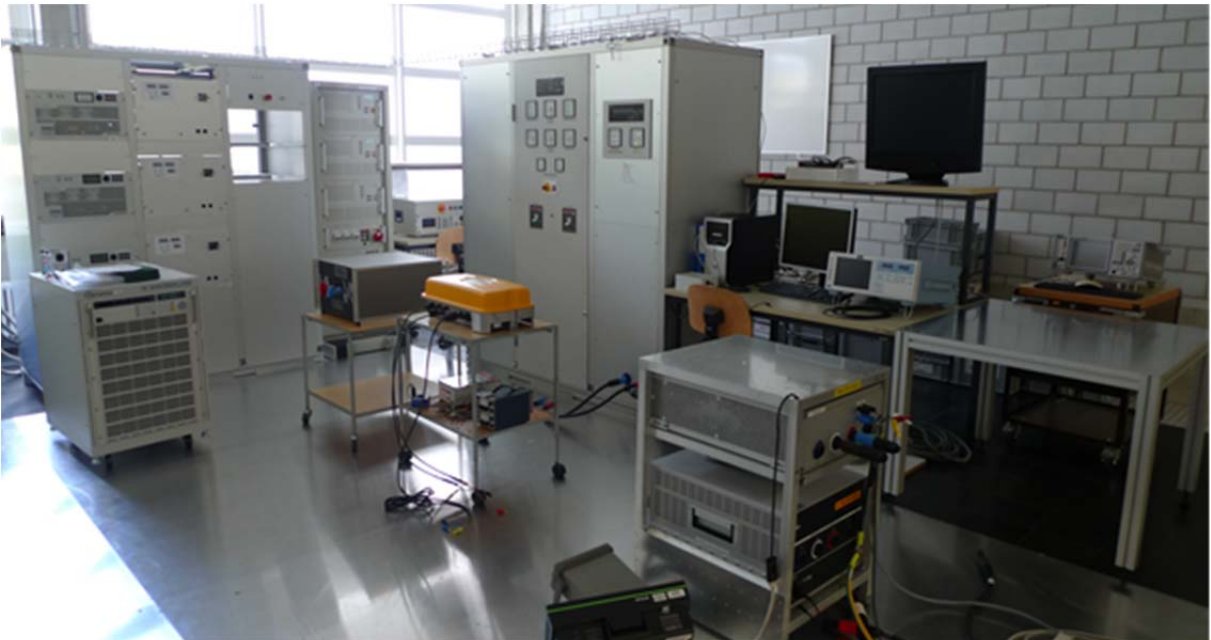
Abb. 2: Der Umzug des 100kW-SolGenSim in den neuen Laborraum für Wechselrichtertests (WRT) war erfolgreich.
