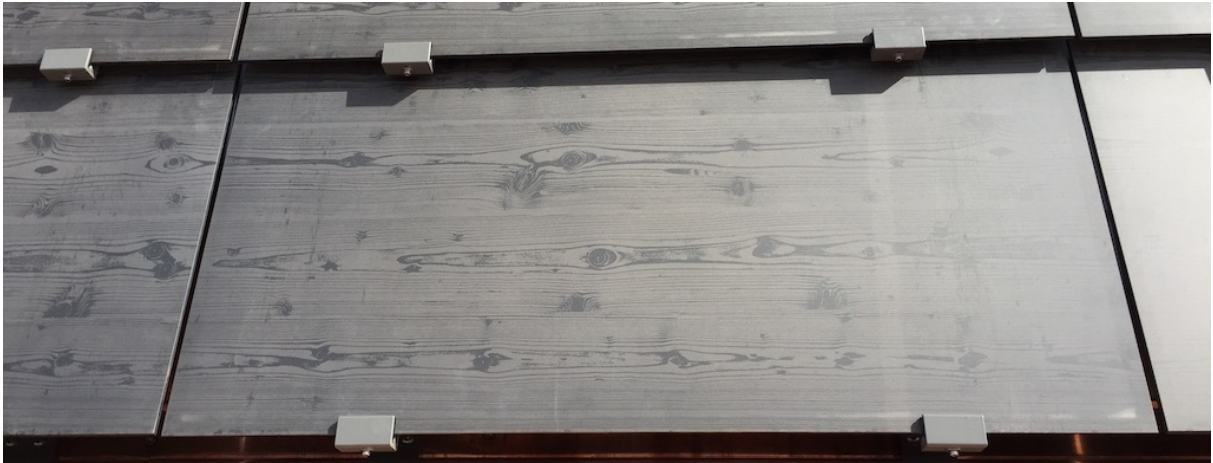
Abb.2: „Holz macht Strom“: PV Panel mit Holzstruktur auf Wunsch der Denkmalpflege Wallis im Aufsetzverfahren hergestellt
