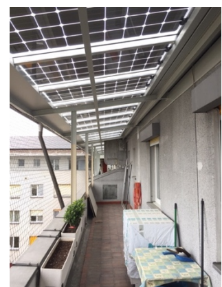
Abb.25 : Überdachung hofseitig mit PV-Modulen
