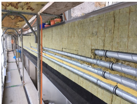
Abb.23: Dämmung im Bau mit integrierter Komfortlüftung
