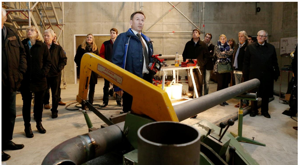
Baustellenbesichtigung der FDP Solothurn, November 2014, Hybridwerk Aarmatt
