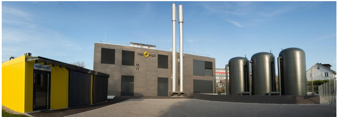
Besucherpavillon auf dem Areal des Hybridwerks Aarmatt
