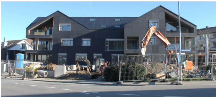
Abb. 2 Bild der Baustelle Ende März 2016 (Quelle: Basler & Hofmann AG)
