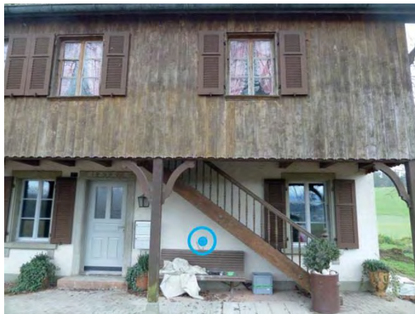
Abbildung 14: Detailansicht der Nordwestwand des Objekts in Aarwangen und Einbauort der Sensoren (Blau).
