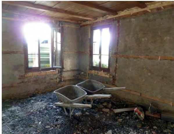
Abbildung 12: Ansicht Westecke des Messobjekts Wohnhaus Aarwangen, an die links die nach Südwest orientierte Wand anschliesst.
