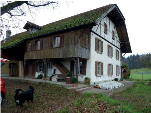
Abbildung 11: Ansicht der Westecke des Messobjekts Wohnhaus Aarwangen, an die links die nach Nordwest orientierte Wand anschliesst.
