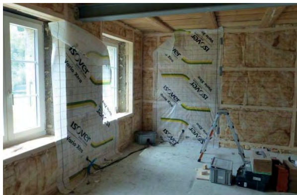
Abbildung 40: Einbauorte der Sensoren innen nach Installation der Dampfsperre.
