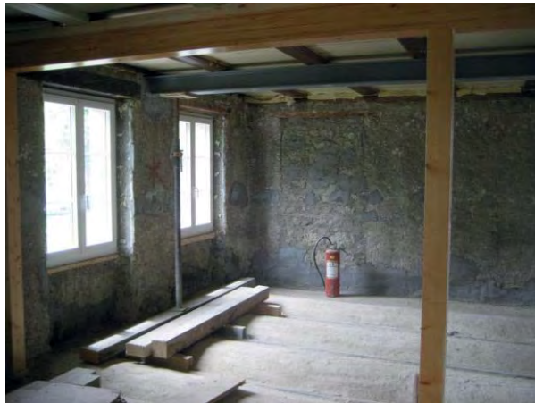
Abbildung 34: Innenansicht der Westecke des Messobjekts Wohnhaus Brüttelen, an die links die nach Südwest orientierte Wand anschliesst.
