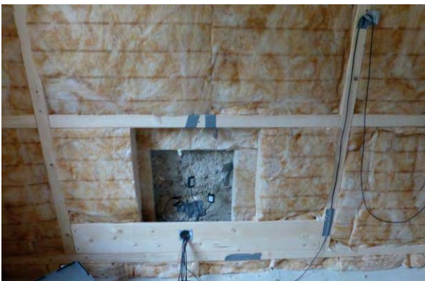
Abbildung 39: Einbau der Sensoren innen nach Installation der Wärmedämmung in der Installations Ebene.
