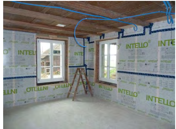
Abbildung 23: Ansicht Westecke nach Einbau der feuchtevariablen Dampfbremse und der neuen Fenster.
