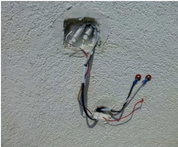
Abbildung 45: Situation aussen Südwestwand nach Installation der Sonden zur Messung der Materialfeuchte und Temperatur im Aussenputz und Mauerwerk (70 mm Tiefe). Die Sonden zur Messung der Materialfeuchte im Mauerwerk sind mit Lack isoliert, um nicht Widerstände im Putz zu messen.
