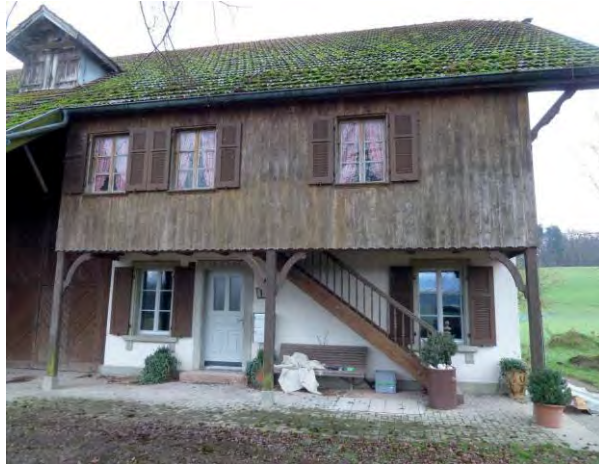
Abbildung 10: Ansicht Nordwestwand des Messobjekts Wohnhaus Aarwangen.
