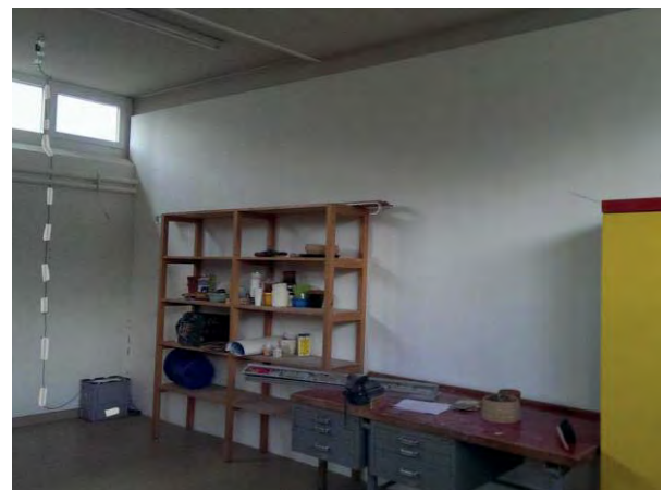
Abbildung 55: Situation innen nach Beendigung der Sanierungsarbeiten mit Raumsensor N-9 oben links und Kiste zur Aufbewahrung der Messtechnik unten links.
