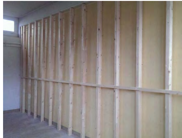
Abbildung 48: Innenansicht der Nordwestecke des Messobjekts Soorpark Bütschwil, an die rechts die nach Nord orientierte Wand anschliesst.
