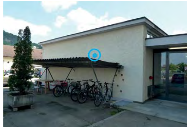
Abbildung 50: Detailansicht der Nordwand in Bütschwil und Einbauort der Sensoren (Blau).
