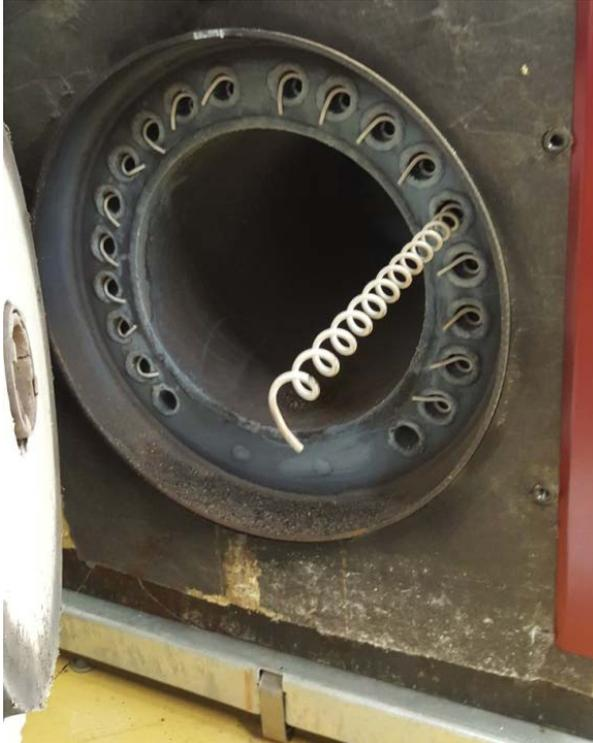
Abbildung 8 Kessel mit offener Tür und sichtbaren Turbulatoren
