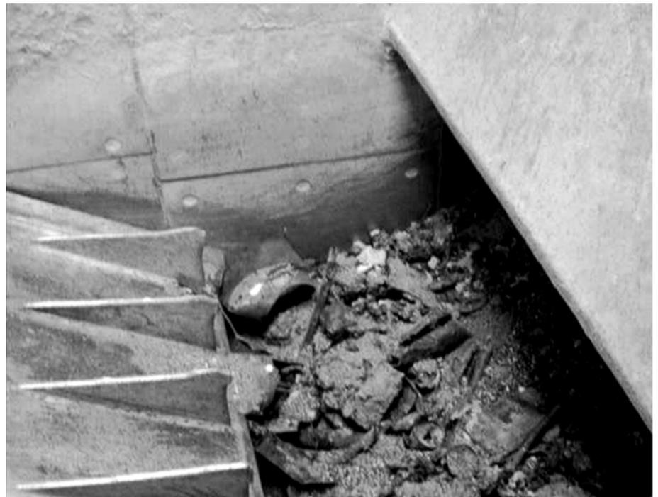
Abb. 1: Trocken betriebener Nassentschlacker
