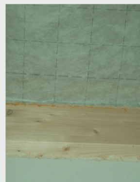
Verkleben der Unterspannbahn
