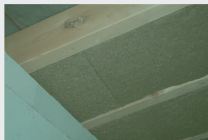
Mit Unterspannbahn und Sparren
