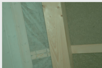
Mit Giebelbalken, Unterspannbahn und Täferung
