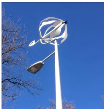
Abbildung 16: Energy-Ball installiert auf Kandelaber an der Roberstenstrasse
