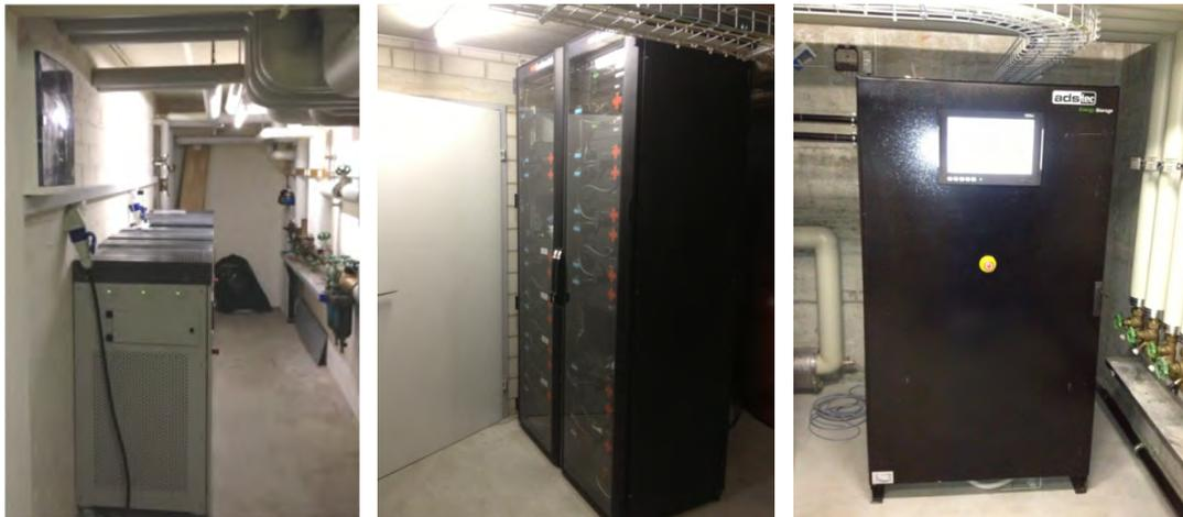
Abbildung 17: Elektrische Energiespeicher
