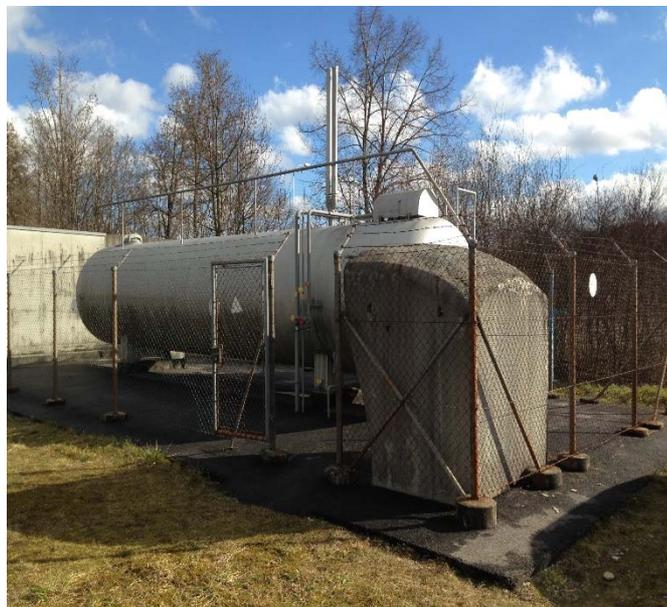
Abb. 6 Propangastank mit Verdampferhäuschen im Hintergrund (Rangierbahnhof Däniken SO)
