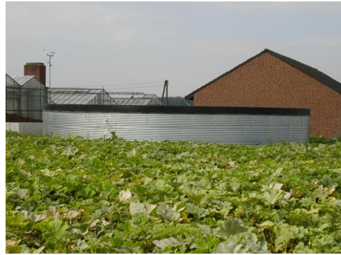
Abbildung 36: Regenwasserspeicher für die Bewässerung von landwirtschaftlichen Kulturen. Links: Folienerdbecken und rechts Stahlbecken
