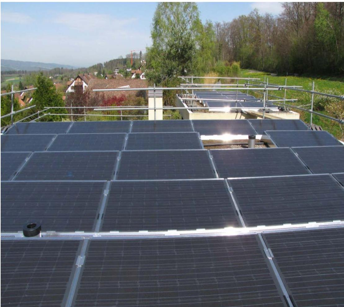
Abb. 4: Foto der fertig gestellten Hybridkollektoranlage im Vordergrund und der Photovoltaikanlage auf dem hinteren Dach (Quelle: Marc Bättschmann, Meyer Burger AG)
