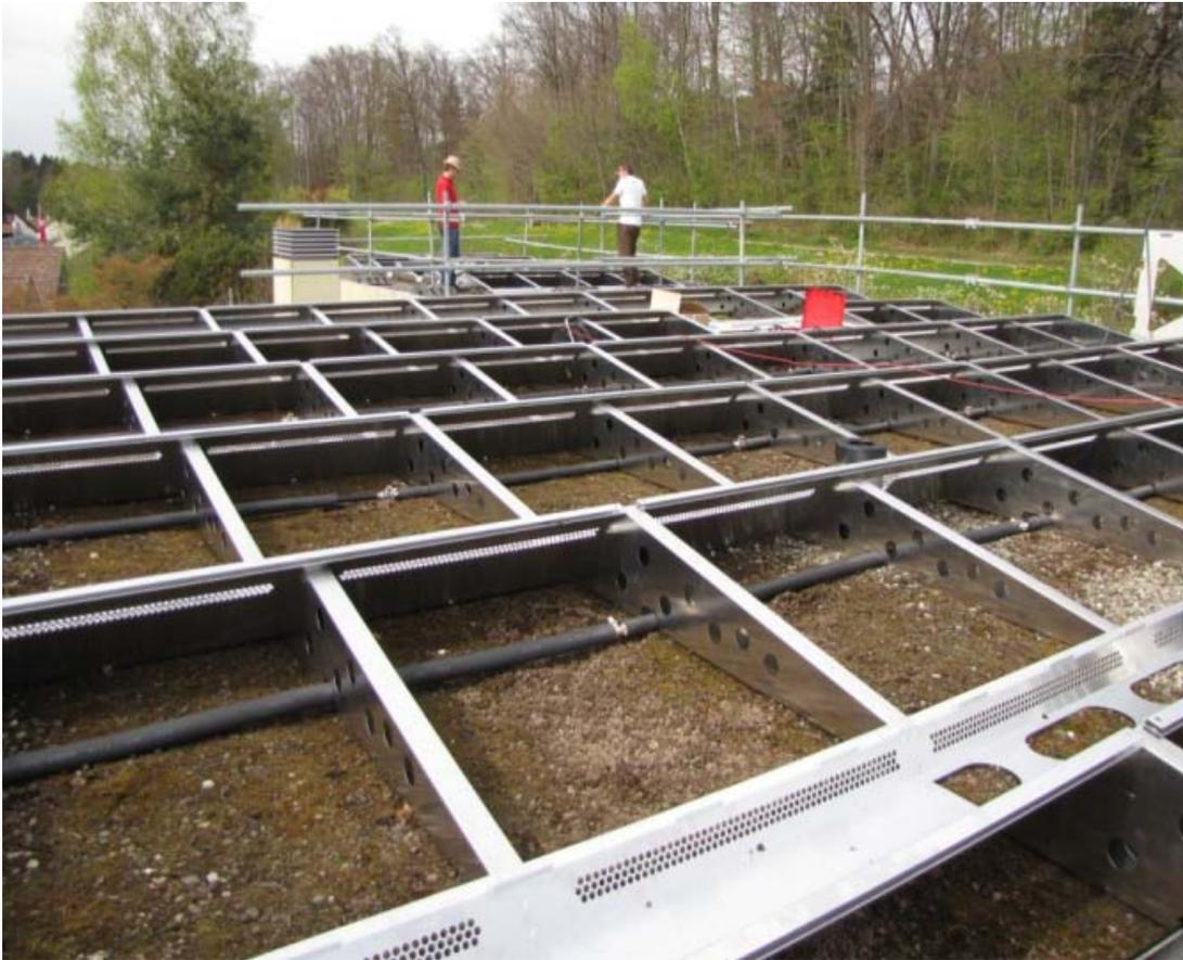
Abb. 5: Foto Aufbau Unterkonstruktion, Vorbereitungen vor der Kollektormontage (Quelle: Marc Bättschmann, Meyer Burger AG)
