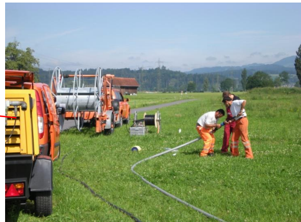
Figure 10 : procédure d'installation de la fibre dans la sonde par soufflage
