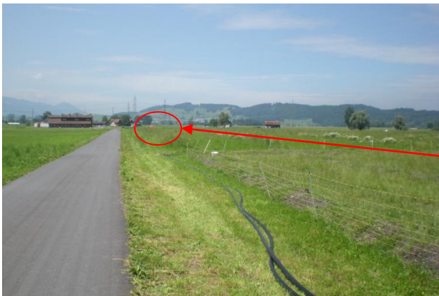
Figure 9 : déroulement de la sonde pour l'installation de la fibre
