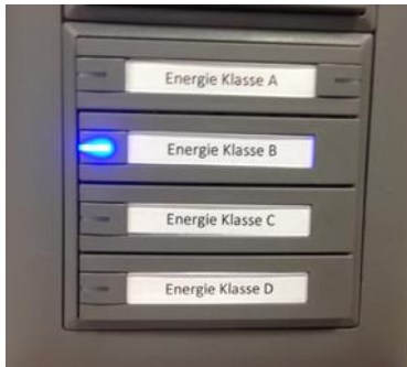
Abbildung 10: Taster zur Umschaltung des GA Programmes
