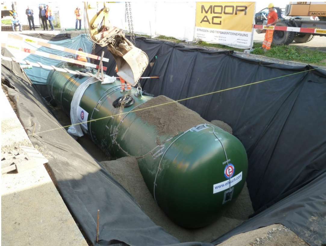
Abb. 4 Einsanden des erdverlegten 5 MPa Tanks
