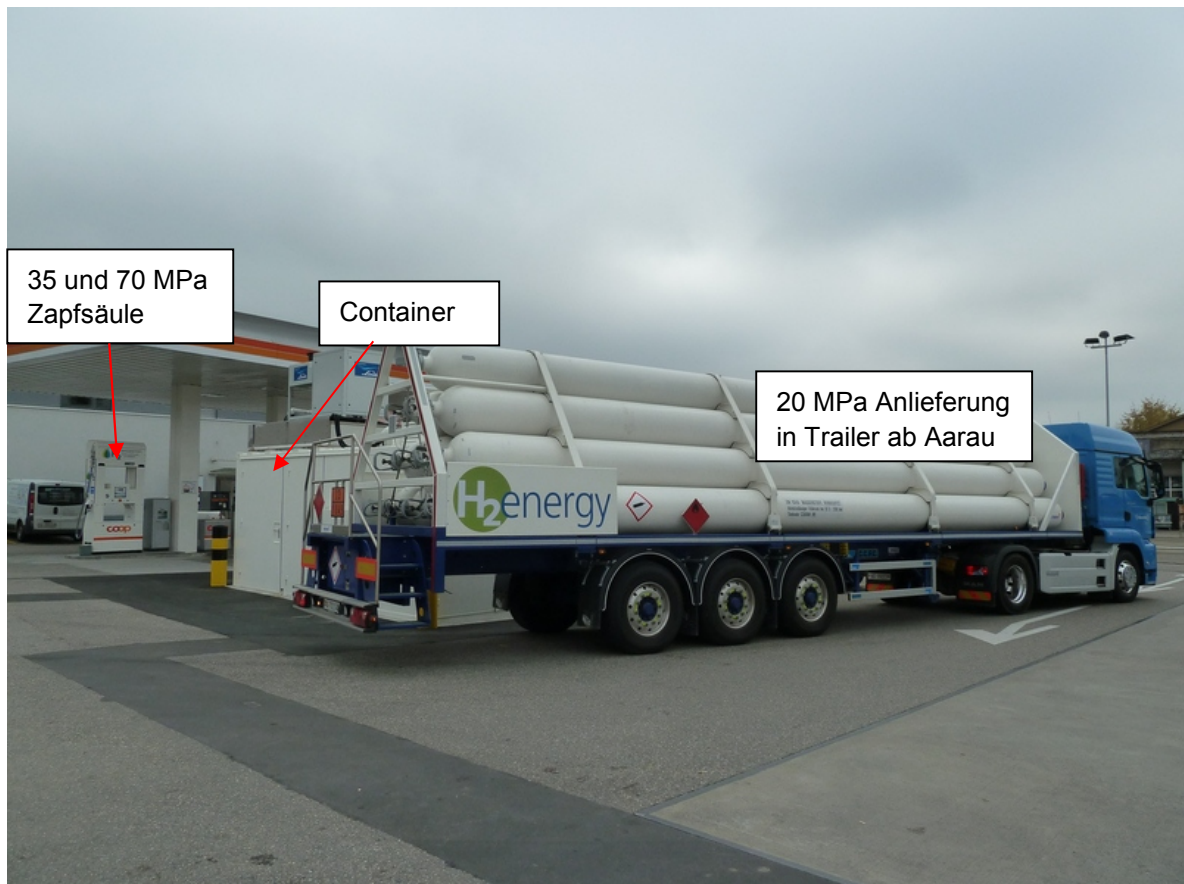
Abb. 6 Ansicht Tankstelle bei H 2 Anlieferung
