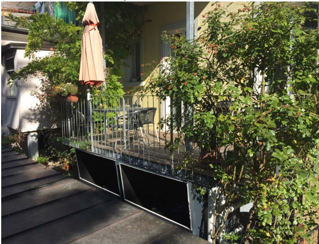
Abb. 6 Luftaustritt der beiden Verdampfer
