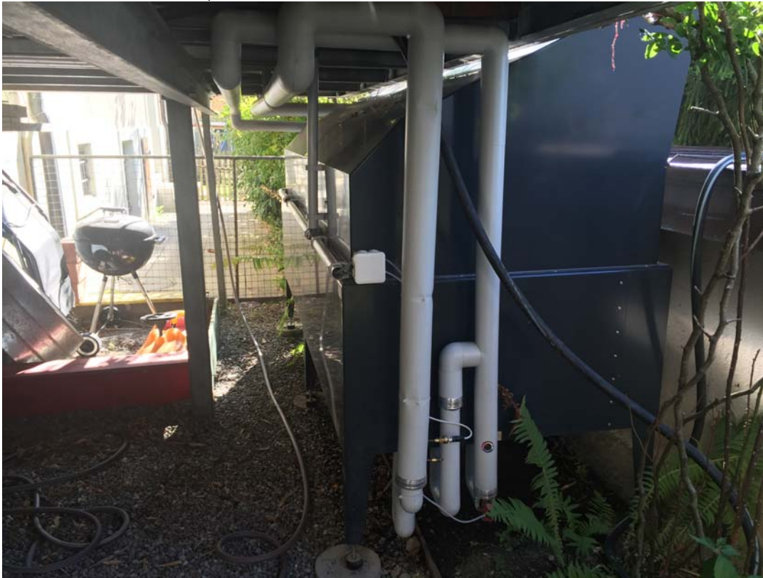
Abb. 6 Luftaustritt der beiden Verdampfer
