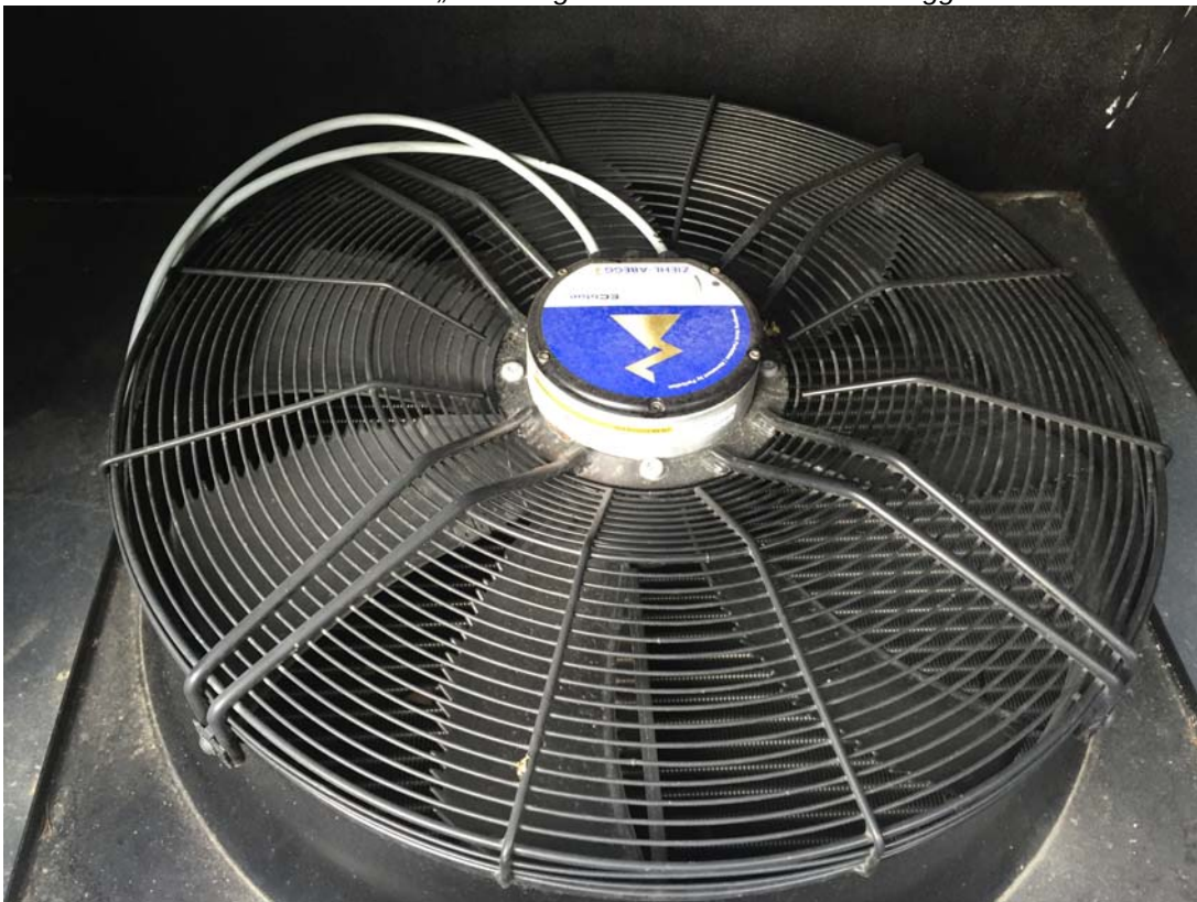
Abb. 10 Flüsterleiser Ventilator: „Eulenflügel“ FE2owlet von Ziehl-Abegg
