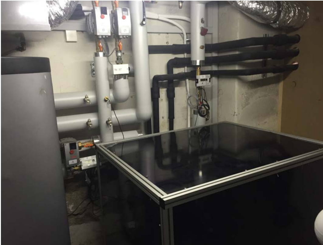
Abb. 4 Abluftanlage mit internem Verdampfer
