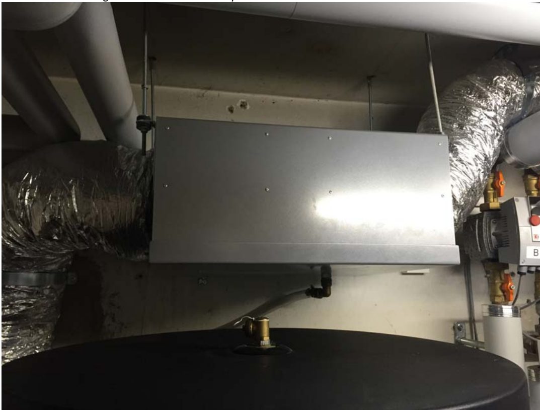
Abb. 4 Abluftanlage mit internem Verdampfer
