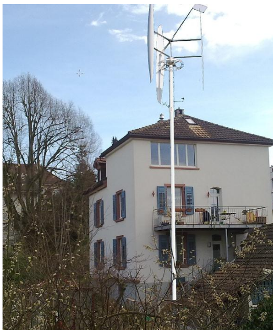
Abbildung 12: Fotomontage einer 3kW Windturbine vom Typ ev300
