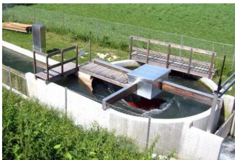
Abbildung 13: Wasserwirbelkraftwerk in Obergrafendorf (A)
