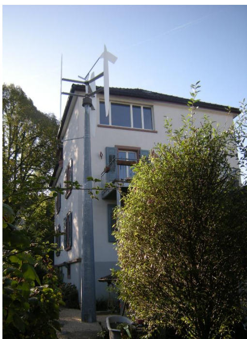
Abbildung 25: Montierte 3.6 kW Windturbine vom Typ ev312 von envergate
