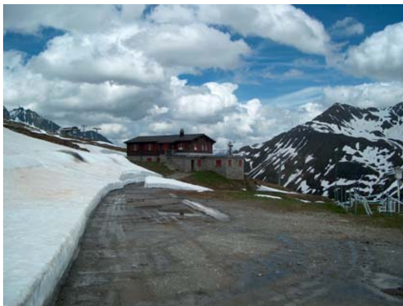
Abbildung 1: Unterkunft Gütsch oberhalb Andermatt (2344 m)
