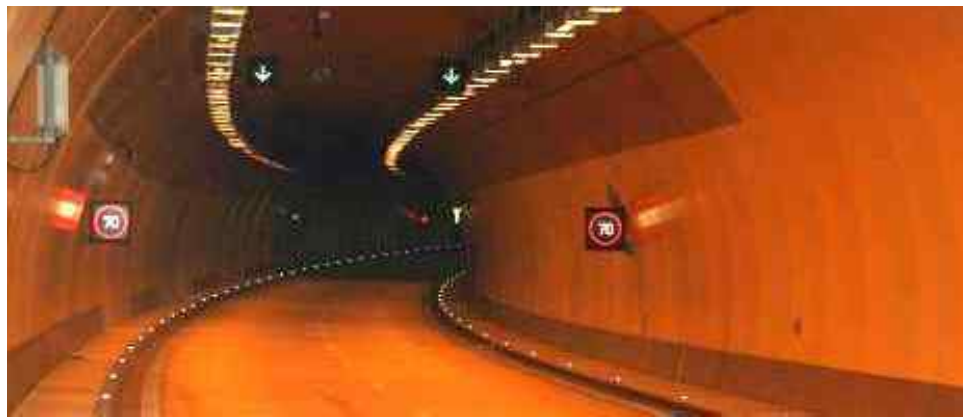
Abbildung 12: Randstein-LED-Beleuchtung mit Lauflichtfunktion im Tunnel Markusbiereg 19
