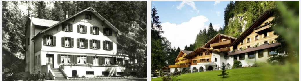
Fig. 17 Hôtel Doldenhorn de Kandersteg jadis et maintenant
