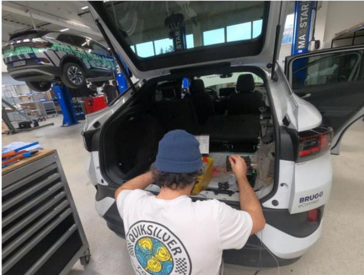
Abbildung 20: Installation Kabelbaum im hinteren Fahrzeugbereich
