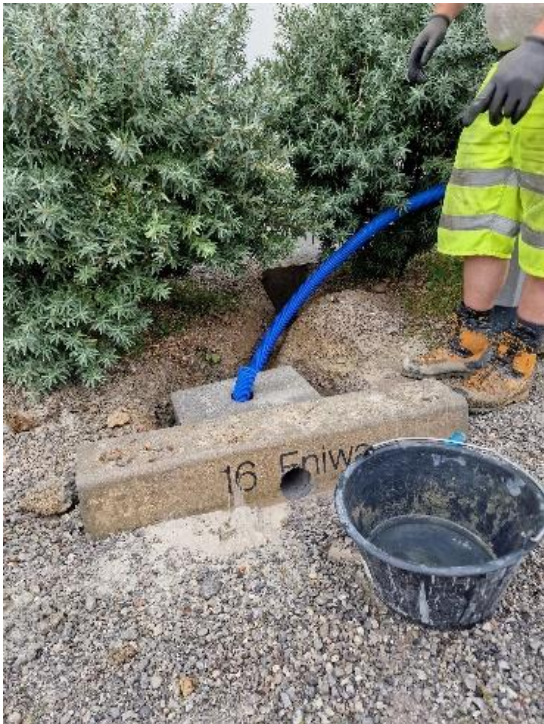
Abbildung 44: Installation des Leerrohrs beim ersten Ladestationsstandort
