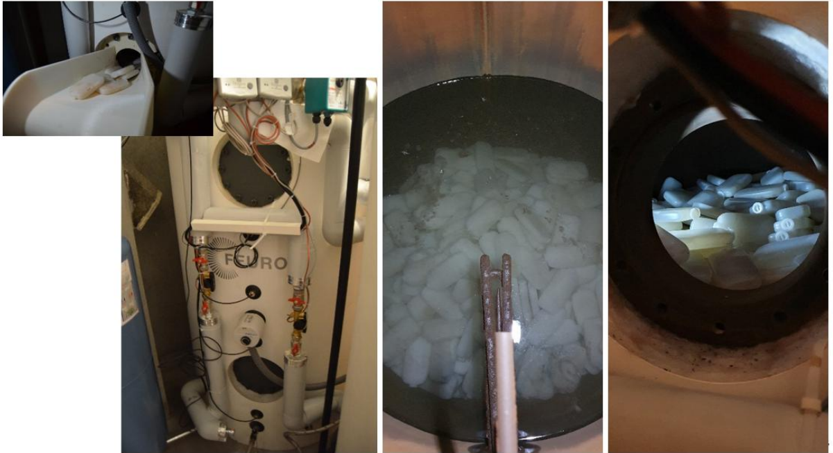
Abbildung 27: Impressions des Pufferspeichers und der Befüllung des Puffers mit Cowa BOOSTER CAPSULES.
