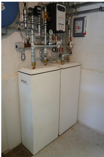
Abbildung 30: Zwei Installationsbeispiele von Pilotanlagen, umgesetzt in Q3 2024. Warmwasser- und Pufferspeicher (links), sowie drei Pufferspeicher (rechts).
