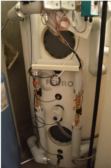
Abbildung 2: links: Geöffneter Speicher für das Befüllen mit Cowa Caps. Rechts: Massblatt des Pufferspeichers Feuron (Quelle: Datenblatt Meier Tobler)
