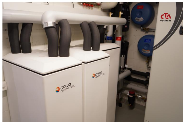
Abbildung 30: Zwei Installationsbeispiele von Pilotanlagen, umgesetzt in Q3 2024. Warmwasser- und Pufferspeicher (links), sowie drei Pufferspeicher (rechts).
