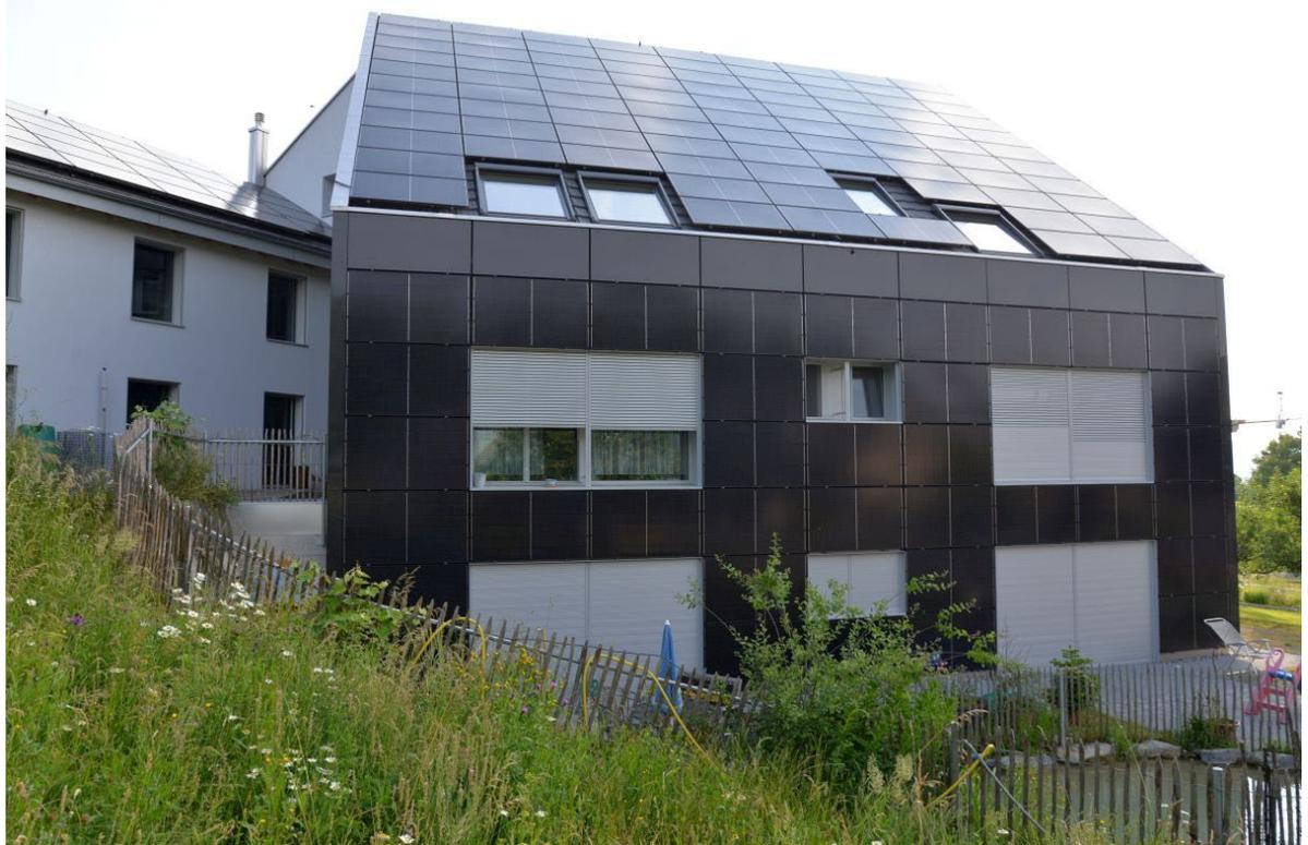
Abbildung 1: Oben: MFH Huttwil mit «nur» solarthermischer Energieerzeugung auf dem Dach. Unten: MFH Anbau Benzenschwil mit «nur» photovoltaischer Energieerzeugung auf der gesamten Gebäudehülle. Beide Gebäude nutzen einen saisonalen Wasser-Wärmespeicher. Quellen: Jenni Liegenschaften AG & synergieplus.ch
