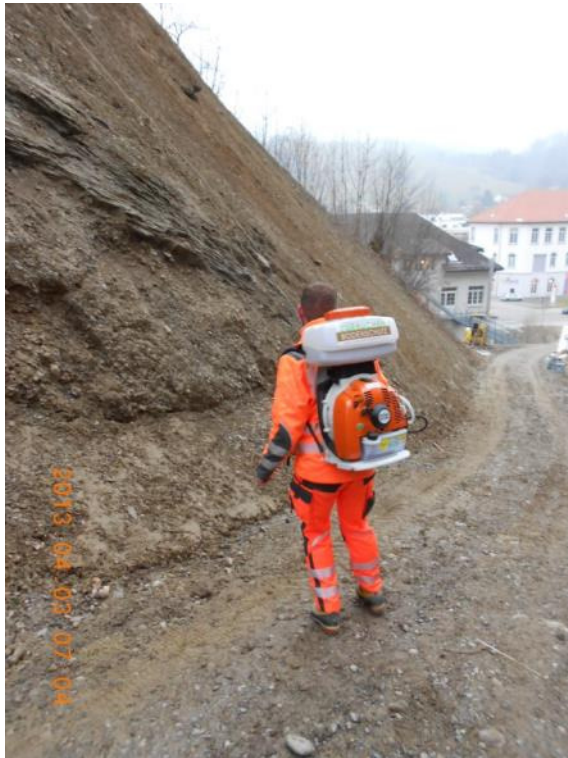
Abbildung 7: Einbringen der Samen unter das Vlies
