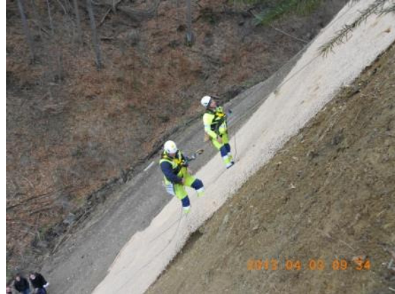
Abbildung 10: Vernagelung des Vlieses am Hang
