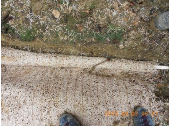
Abbildung 9: Bergseitige Verankerung des Vlieses
