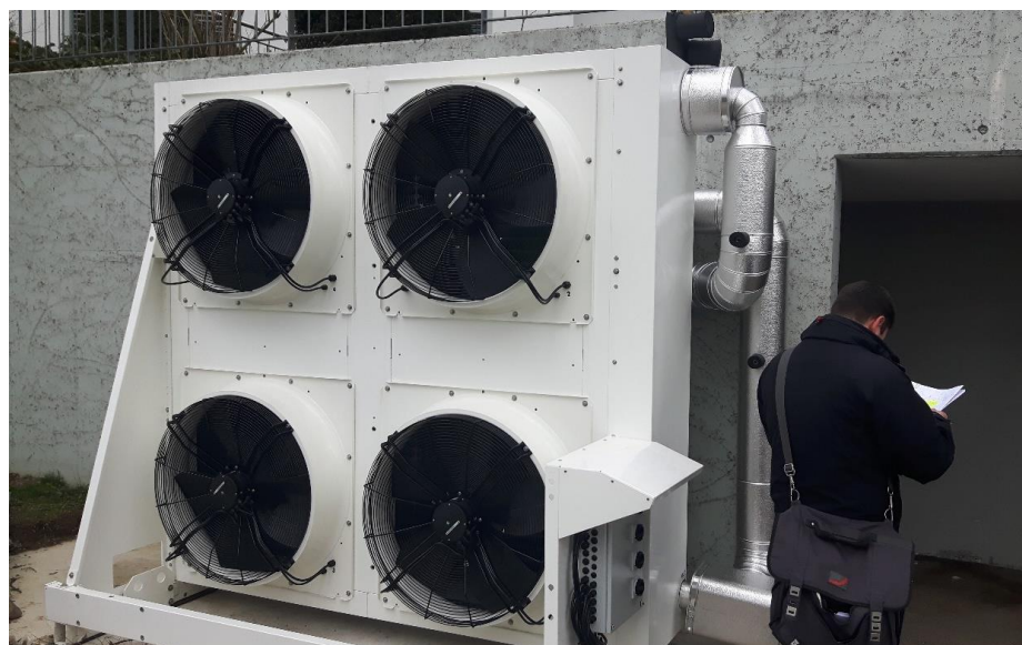
Abbildung 56: Luftwärmetauscher in der MFH-Siedlung Ettenbergstrasse.
