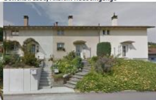
Bettenstrasse, Ansicht Hauseingänge
