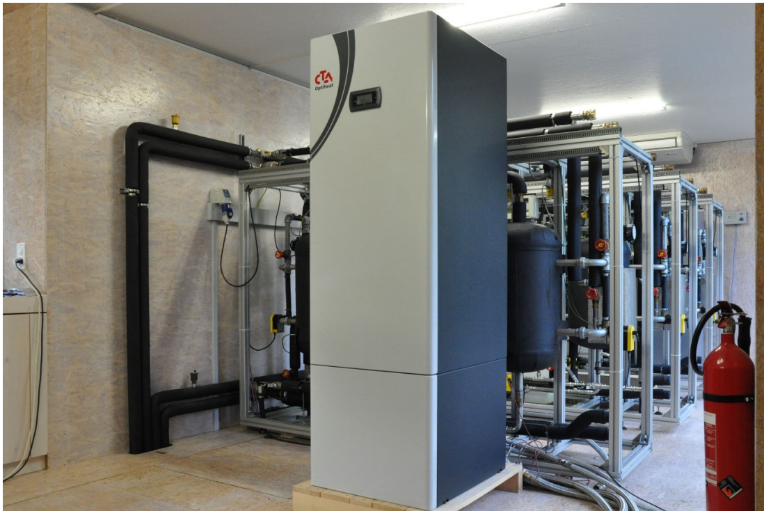
Abbildung 65: Wärmepumpe CTA OH I 4esr TWW mit Warmwasserspeicher
