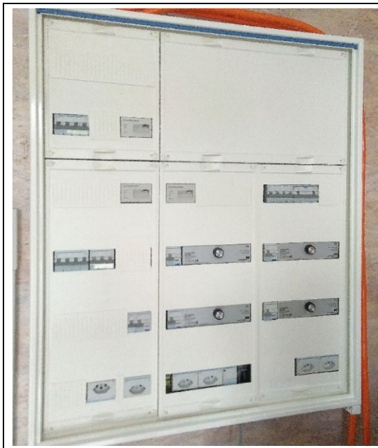
Abbildung 62: Hausverteiler mit Energy-Metern, SPS-Steuerung, Messwandlern und Haushaltsstrom-Emulatoren
