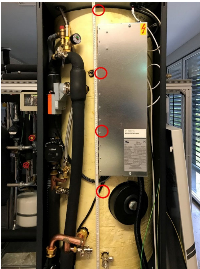
Abbildung 68: Temperaturmessstellen auf vier verschiedenen Höhen im TWW-Speicher
