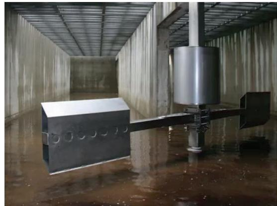
Abbildung 35: Separator (links), Puffersilo (rechts)
