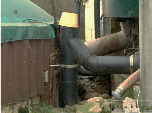
Freispiegelleitung Zulauf BGA unterflur
