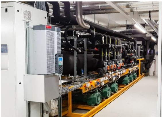
Abbildung 9: Reversible CO 2 -Wärmepumpe.
