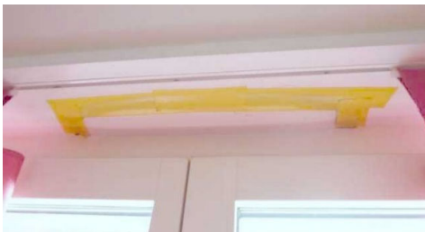
Abbildung 78: oben: Fensterlüfter innen, unten: abgeklebter Fensterlüfter (10.OG)
