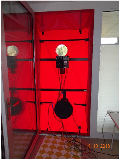
Abbildung 10: Blower-Door, Einbau in eine Wohnungseingangstüre.
