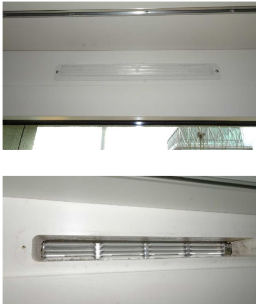
Abbildung 56: oben: Fensterlüfter von innen, unten: Fensterlüfter von innen, geöffnet
