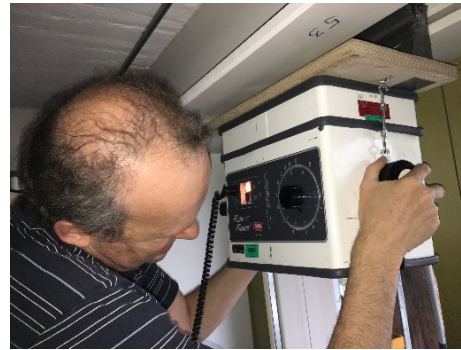
Abbildung 9: Messung Zuluftvolumenstrom
