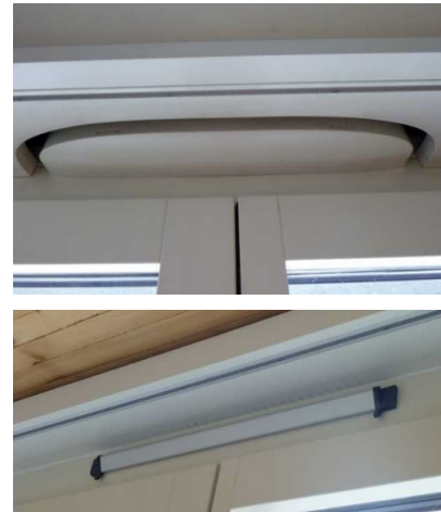
Abbildung 25: Fensterlüfter im oberen Bereich des Fensters.
