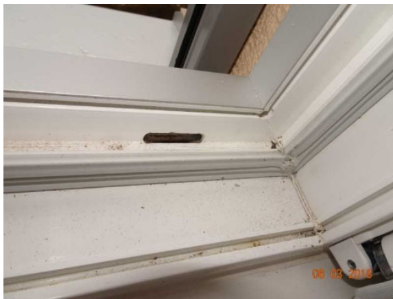
Abbildung 66: oben: Falzlüfter im Rahmen, unten: Schmutzablagerungen
