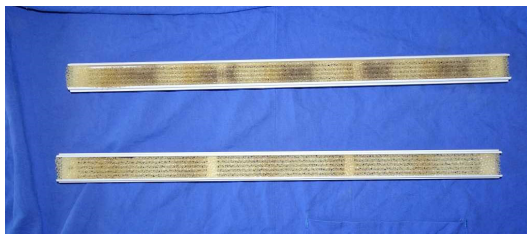
Abbildung 72: oben: Fensterlüfter innen, unten: verschmutzter Fensterlüfter (Filter nicht gereinigt)
