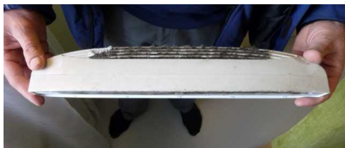
Abbildung 74: oben: Fensterlüfter innen, unten: verschmutzter Fensterlüfter (Filter nicht gereinigt)
