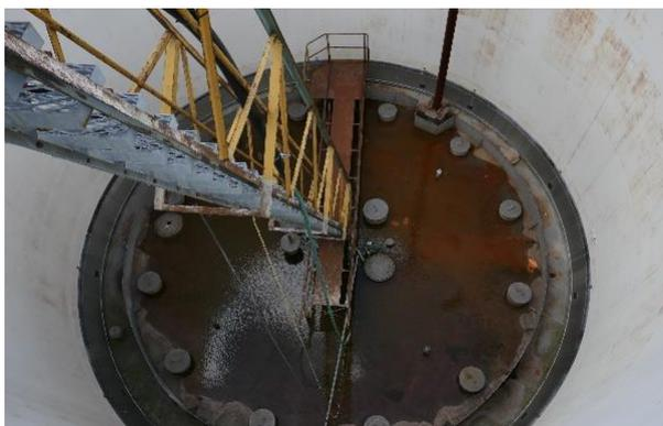
Figure 14 : Vue de dessus d'une cuve avec toit flottant
