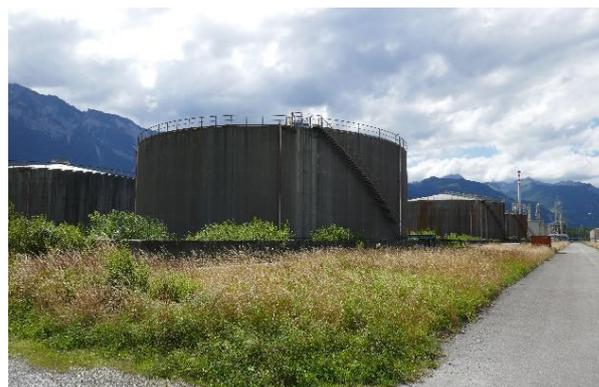
Figure 13 : Vue des cuves à toit fixe
