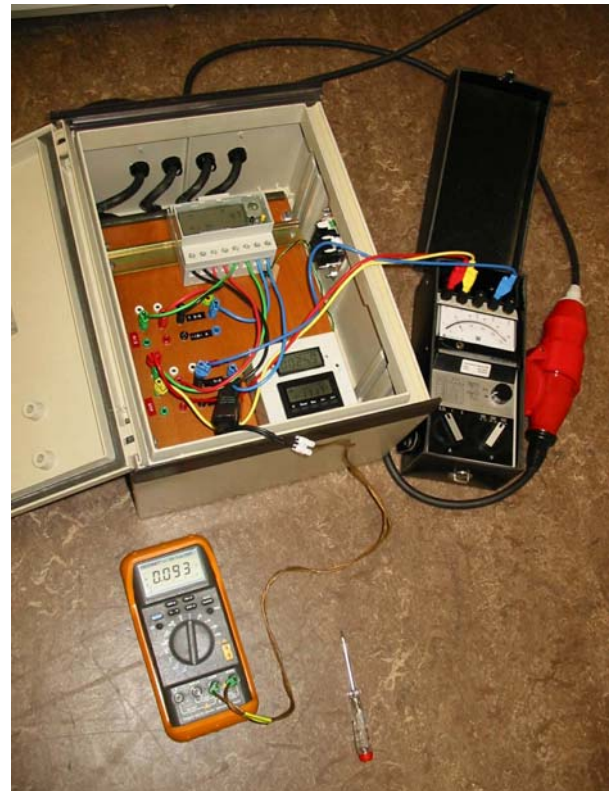
Fig. 3.2 Messausrüstung für Standby-Messungen (EMU 32 dreiphasig, umsteckbare Ein-/Ausgänge, Drehspul-Wattmeter, Stromzange/ Vielfachmessgerät)
