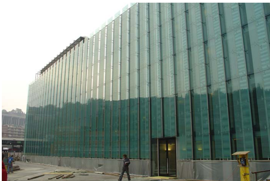
Figura A1.3 : Facciata Nord-Est.
