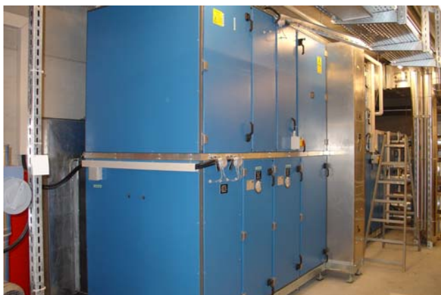
Figura A1.20 : Impianto di climatizzazione sul tetto.
