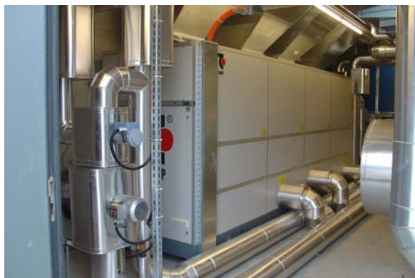
Figura A1.17 : PdC aria-acqua sul tetto. Figura A1.18 : Collettori TABS®.
