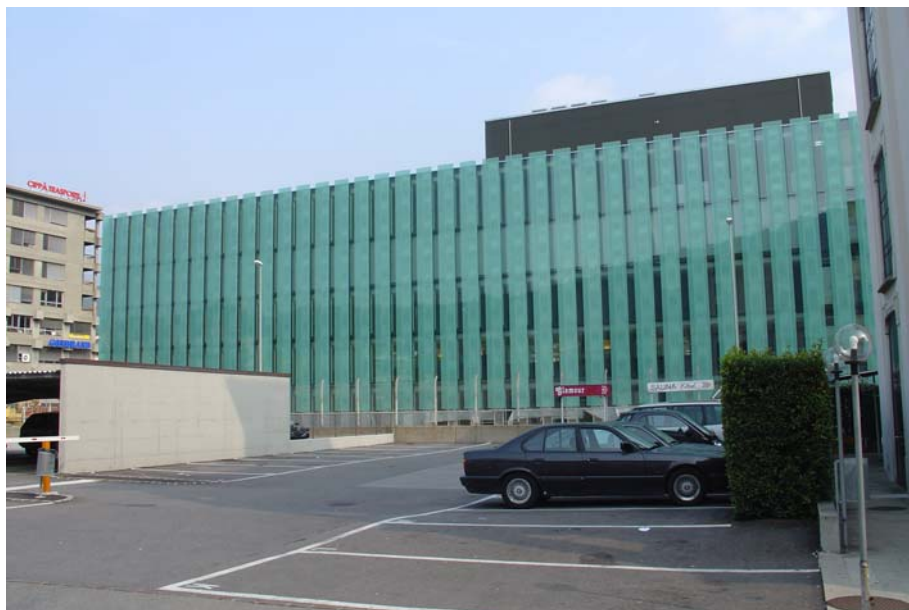
Figura A1.2 : Facciata Sud-Ovest.
