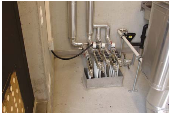
Figura A1.17 : PdC aria-acqua sul tetto. Figura A1.18 : Collettori TABS®.
