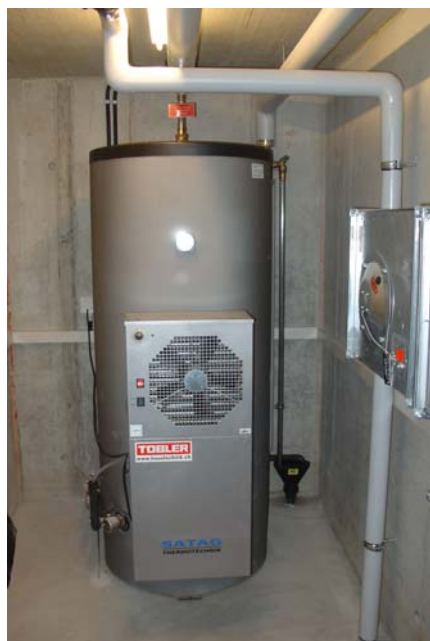
Figura A1.19 : PdC aria-acqua al piano cantina.
