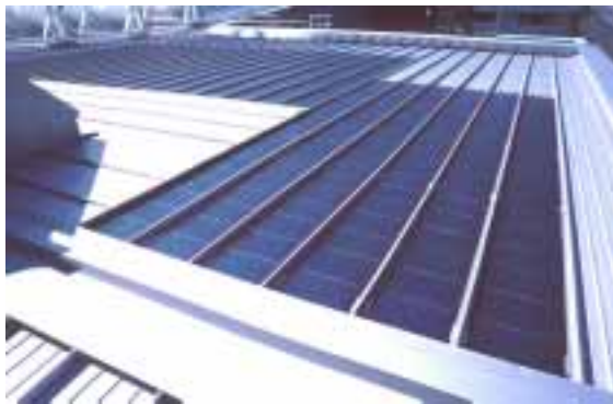
ill. 6: Toit PV métallique isolé thermiquement, à pièces emboîtées. Photo: NET SA
