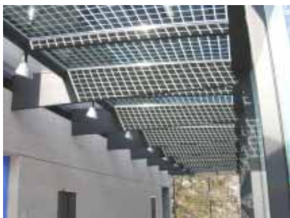
ill. 8: Modules à vitrage isolant de l'École cantonale de Stadelhofen, Photo: NET SA
