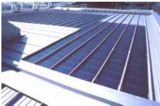
Bild 6: PV Metallfalzdach thermisch isoliert Foto: NET AG
