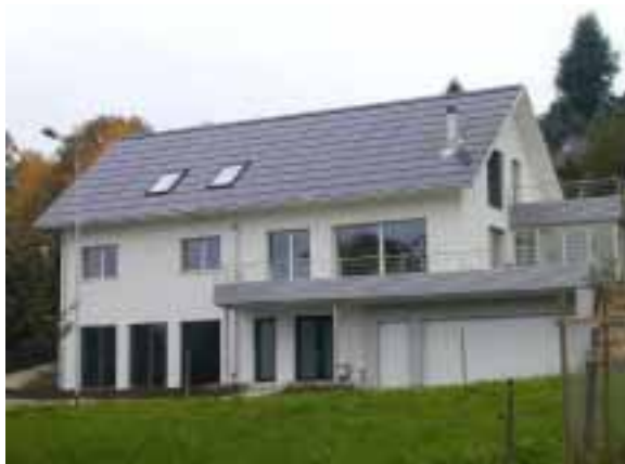
Bild 4: Dachintegration mit SOLRIF Foto: Enecolo AG
