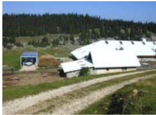
Bild 19: Autonome Anlage Alp Amburnex (Unterstand) (Bildquelle: Services industriels Lausanne)
