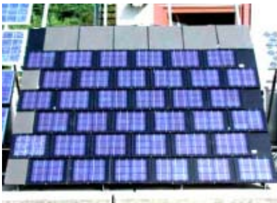
Bild 20: Teststand mit Sunplicity Dachziefern (Bildquelle: TISO)
