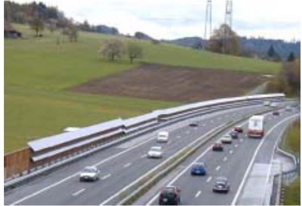
Bild 17: Schallschutzanlage A1 Safenwil (Bildquelle: BFE)
