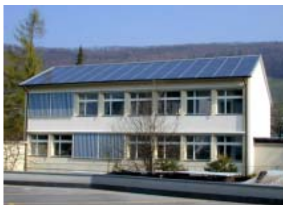
Figure 31: Intégration en toiture à Wettingen, de 12.75 kW c (Photo: NET)
