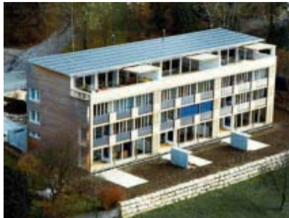
Figure 15: Intégration en toiture, immeuble Sunny Woods, à Zurich, puissance installée 16 kW c (Photo: Architekturbüro Beat Kämpfen)
