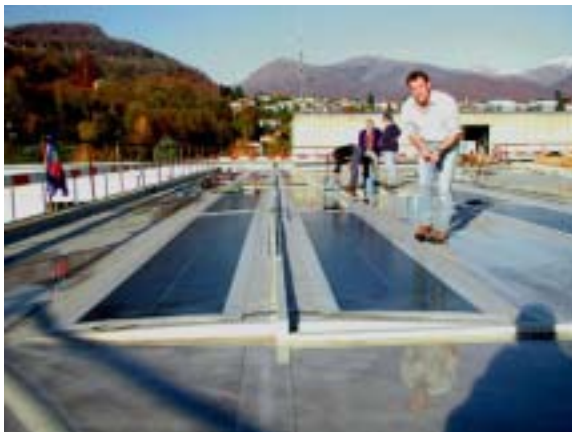
Figure 18: Montage de l'installation CPT Solar à Trevano (TI) (Photo: LEEE-TISO)
