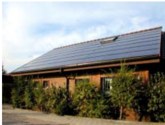
Figure 19: Intégration en toiture du Foyer Weiermat des éclaireurs, à Köniz (BE) (Photo: NET)
