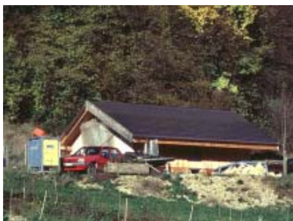
Figure 20: Installation PV autonome de 3 kW c intégrée en toiture à Soyhières (JU) (Photo: NET)
