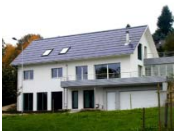
Figure 13: La maison solaire Erni, avec le système SOLRIF d'intégration en toiture (Photo: Enecolo)
