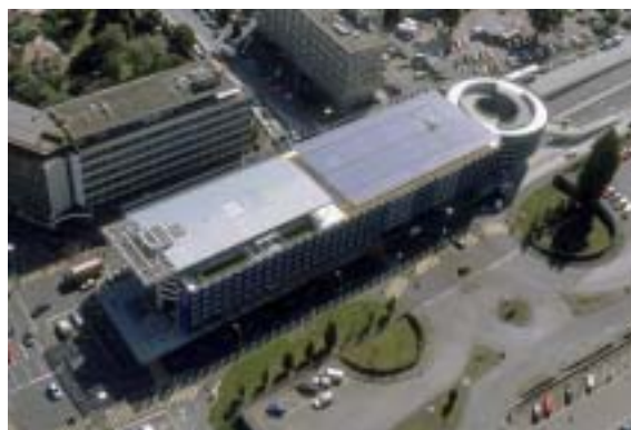
Figure 17: Intégration en toiture du Parking de l'Etoile, à Genève (Photo: Sunwatt Bio Energie)
