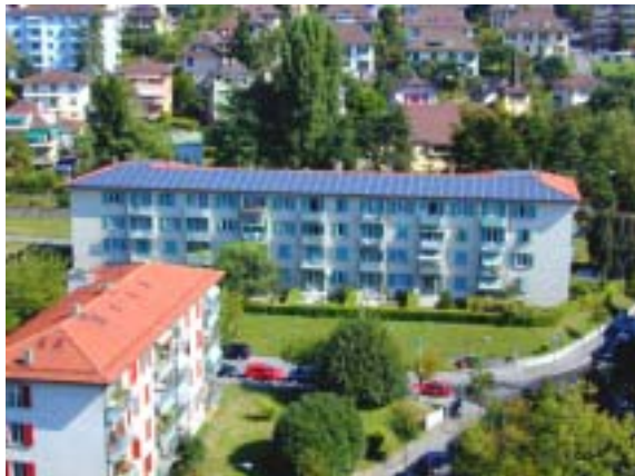
Figure 14: Système SOLRIF d'intégration en toiture, immeuble Florency, à Lausanne (Photo: NET)
