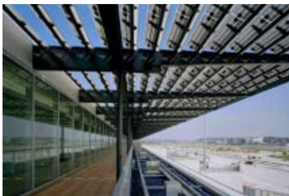
Figure 16: Installation PV d'ombrage du Dock Midfield, à l'Aéroport de Zurich-Kloten (Photo: unique / Ralph Bensberg)
