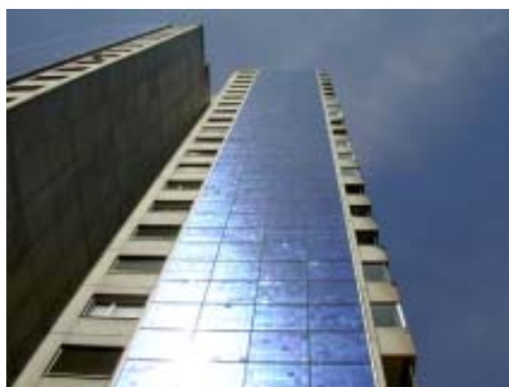
Figure 21: Façade de 80 kW c à Berne-Wittigkofen (Photo: NET)
