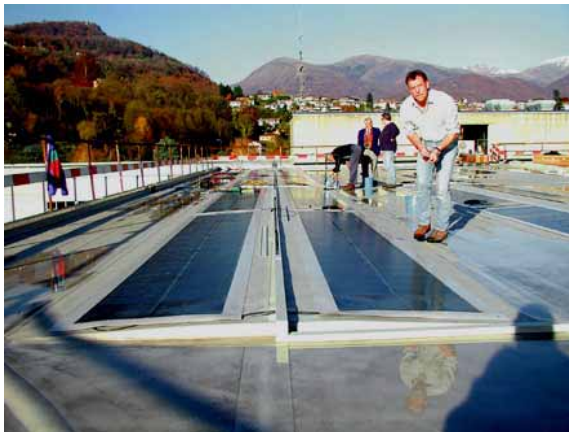
Figur 18: Montage der Anlage CPT Solar Trevano (Bildquelle LEEE-TISO)
