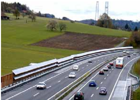
Figur 34: 75 kWp Schallschutzanlage A1 Safenwil (Bildquelle BFE)
