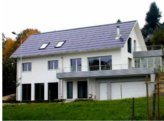
Figur 13: Solarhaus 'Erni' mit SOLRIF Dachintegration (Bildquelle Enecolo)
