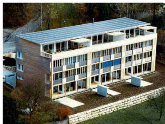
Figur 15: 16 kWp Dachintegration SunnyWoods (Bildquelle Architekturbüro Beat Kämpfen)
