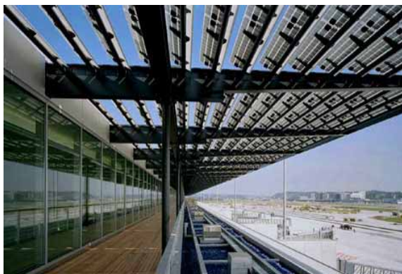
Figur 16: PV-Beschattungsanlage Dock Midfield (Bildquelle unique / Ralph Bensberg)
