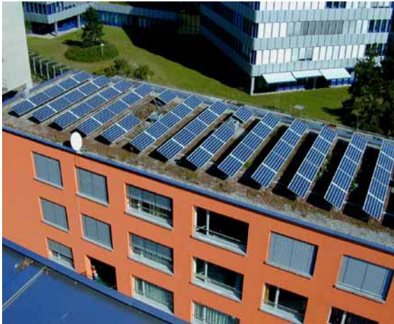
Figur 28: Gründachanlage Solgreen Kraftwerk 1 (Bildquelle NET)
