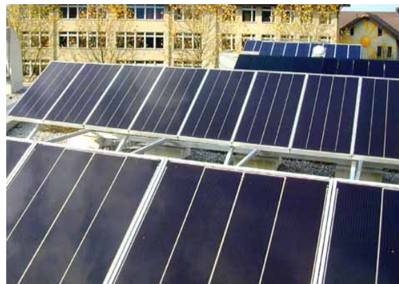
Figur 37: 3x1 kWp Testanlagen Newtech Burgdorf (Bildquelle NET)
