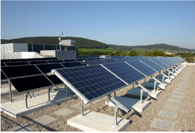
Figur 9: 12,5-kW-P&D-Anlage mit fünf verschiedenen Modultechnologien (Quelle: EKZ).
