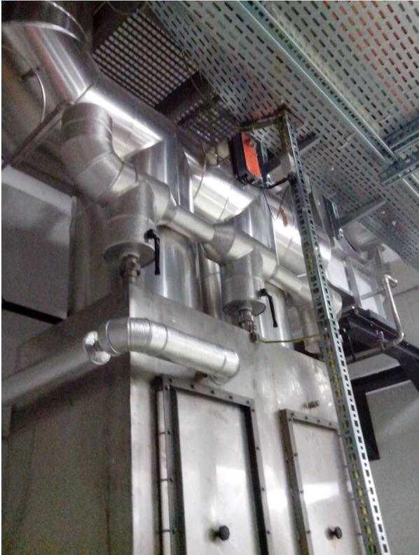
Lamellenabscheider zur Entschlammung des Kondensatwassers
